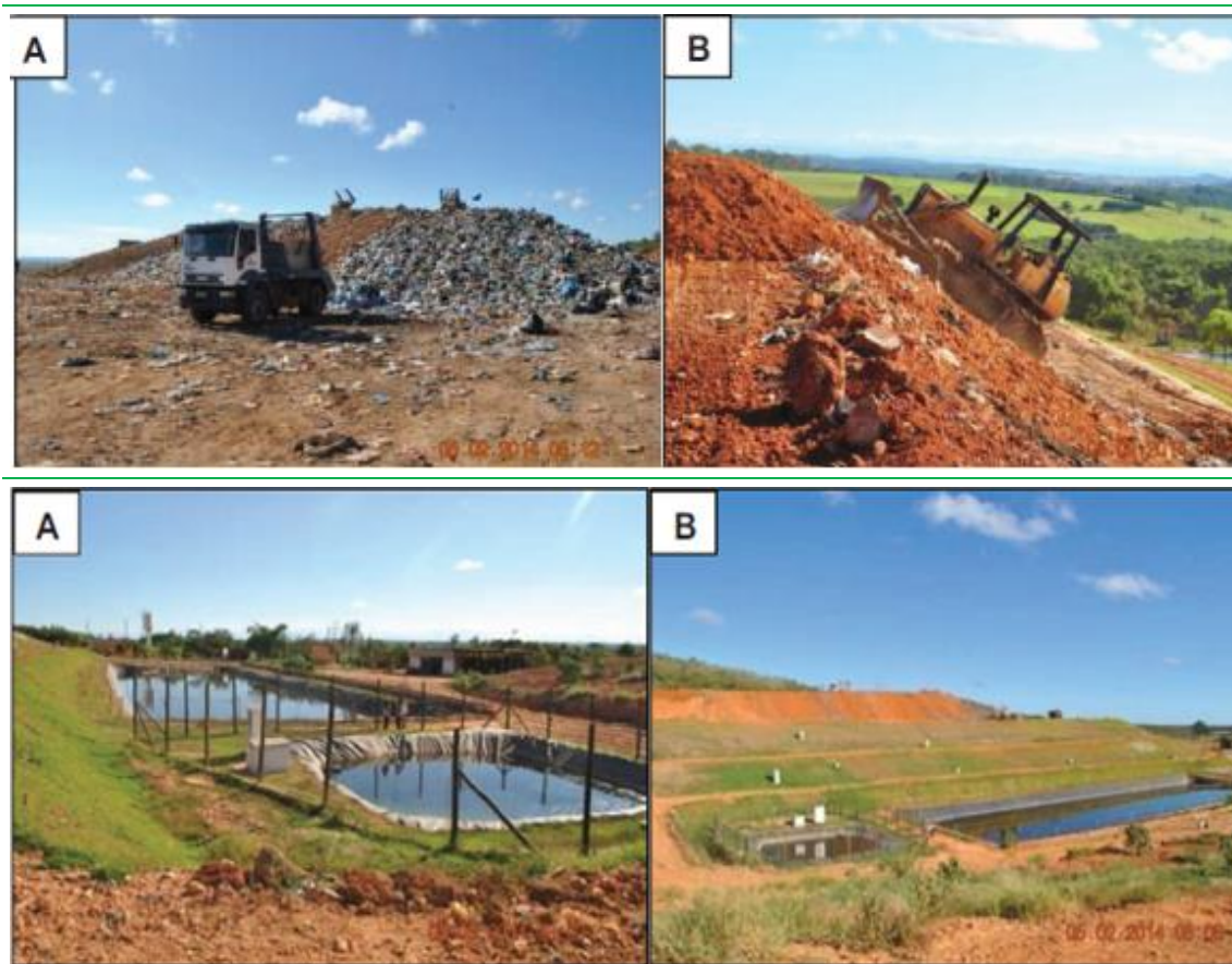
Figura 3.14 – Etapas de serviço no aterro sanitário utilizado por Sete Lagoas.
